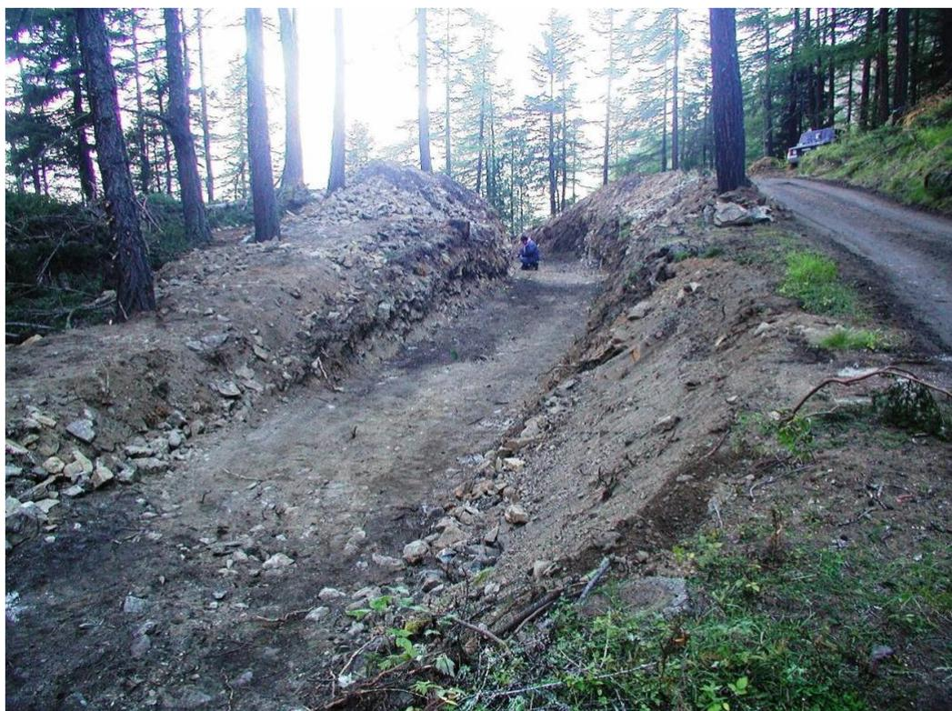
*Fig. 3. Sito fusorio di Ételey – Lo scavo realizzato per la posa della condotta (foto Castello P.)*
